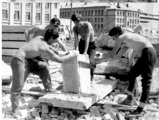
Строительство корпуса К-2
